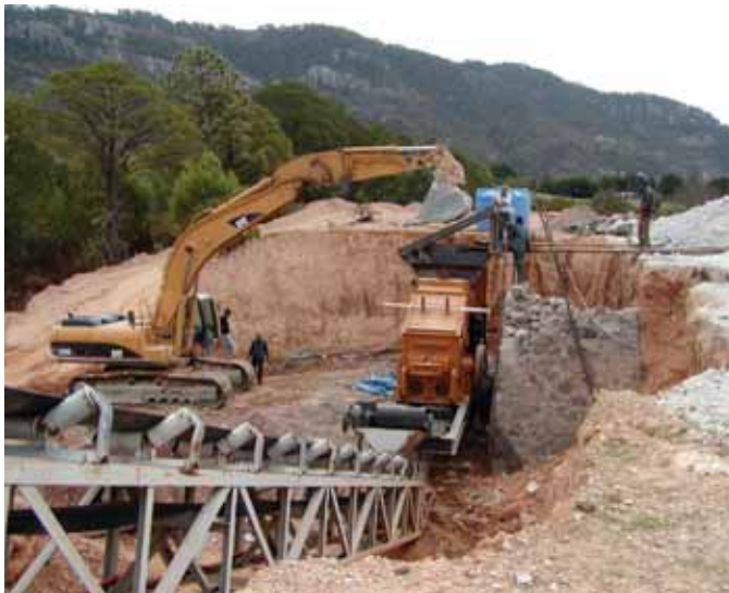
Proceso de excavación de la mina.
