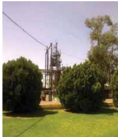
Vista de las instalaciones de Química Central.
