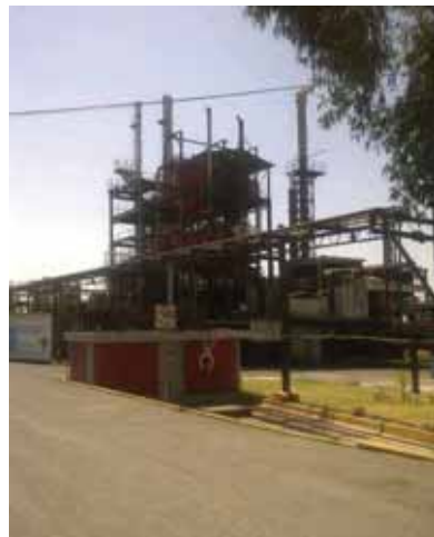
Vista de la entrada de Química Central-Arges.
